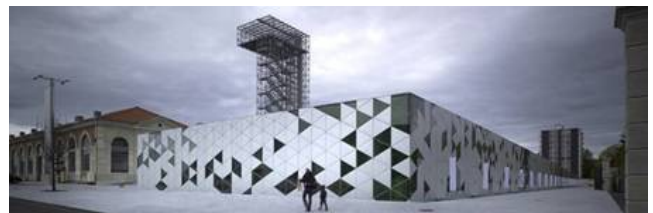
Cité du Design à Saint-Etienne – LIN architectes - © LIN
